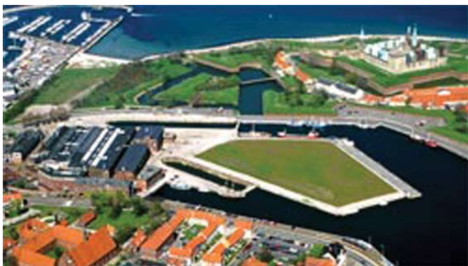
Området idag. Hallbyggnaderna på varvshalvön är rivna. Kronborg i fonden med sin delvis amputerade försvarsanläggning. Den asfalterade vägen går längs bastionerna ut till Nordre Mole.
